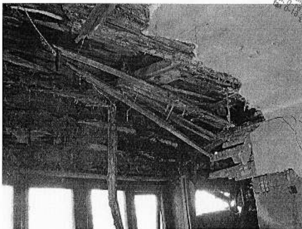
Fot. 10. Widok stropu od strony wewnętrznej budynku.
