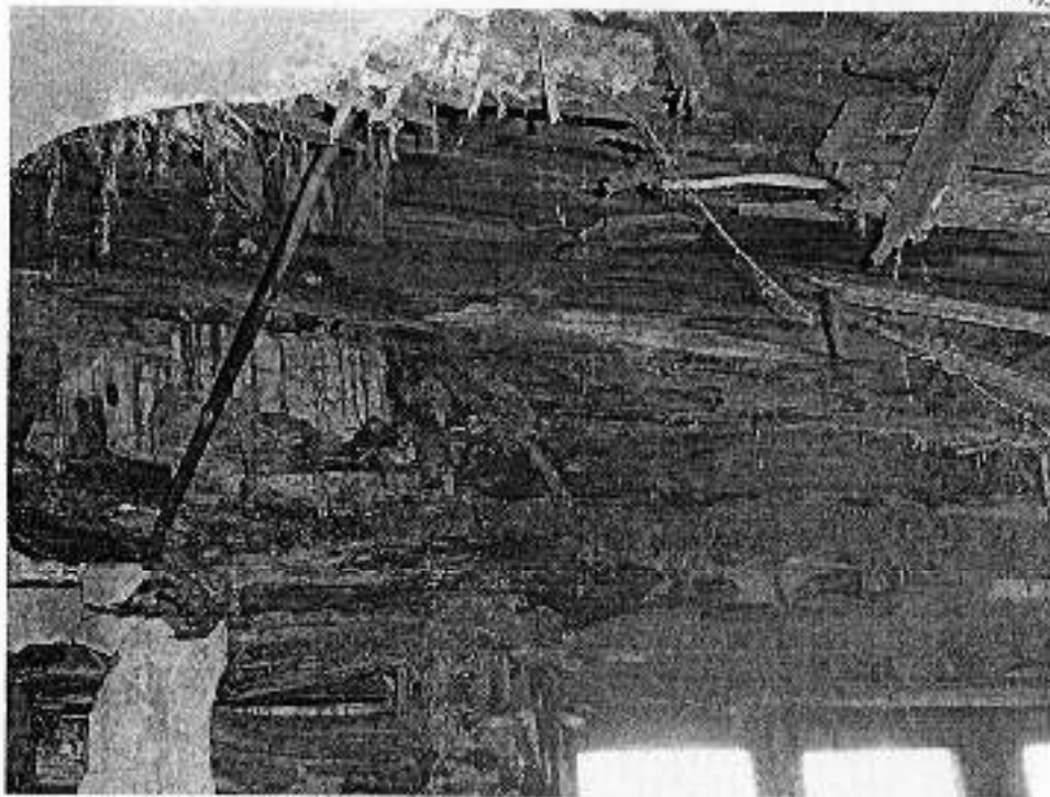
Fot. 8. Widok ściany i stropu od strony wewnętrznej budynku.
