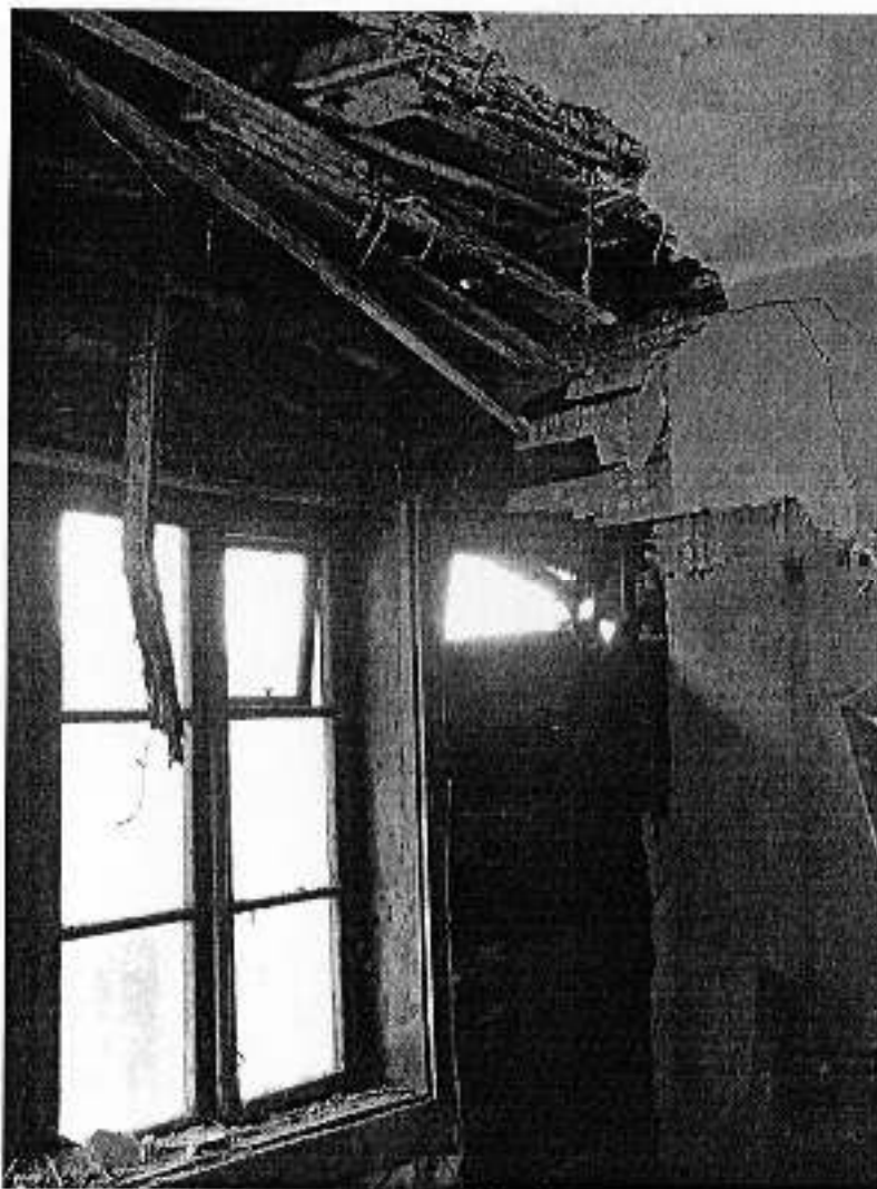
Fot. 12. Widok ścian i stropu.
