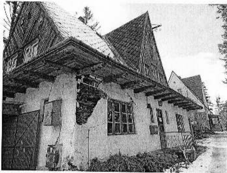
Fot. 1. Ogólny widok budynku.
