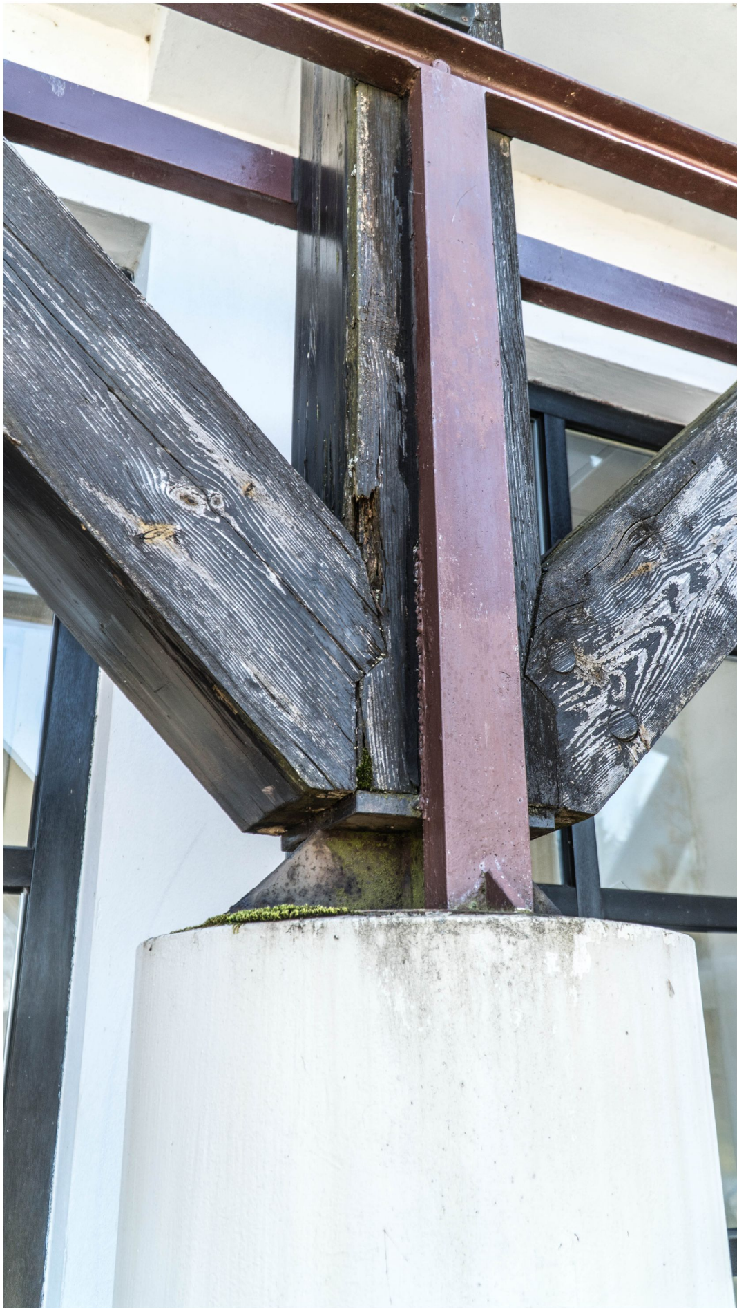
podpora ryzalitu w elewacji zachodniej
