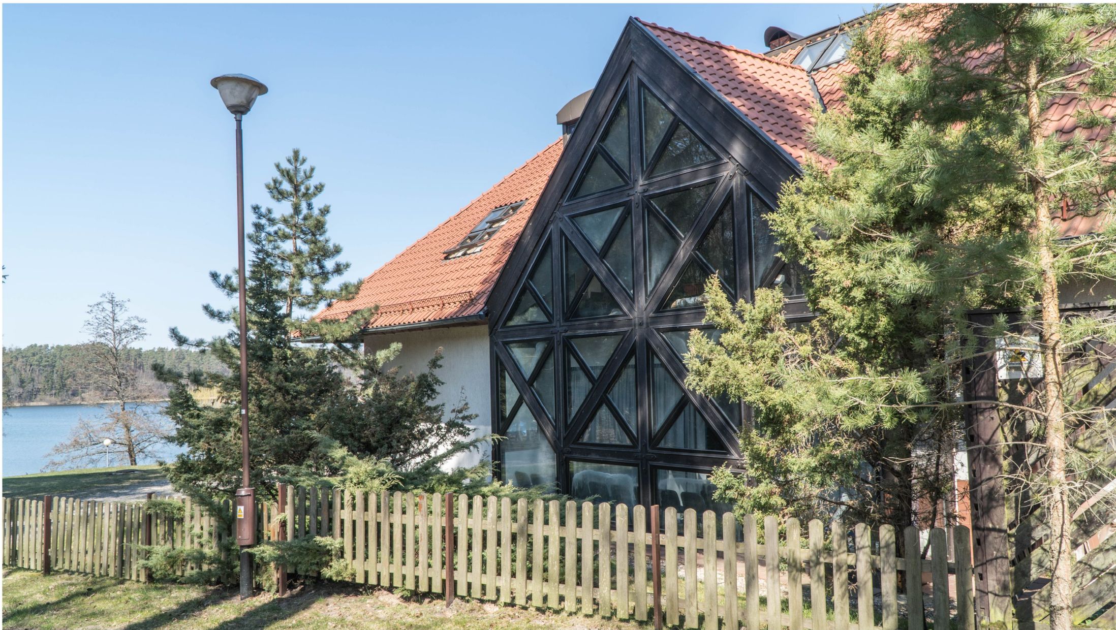
ryzalit elewacji południowej
