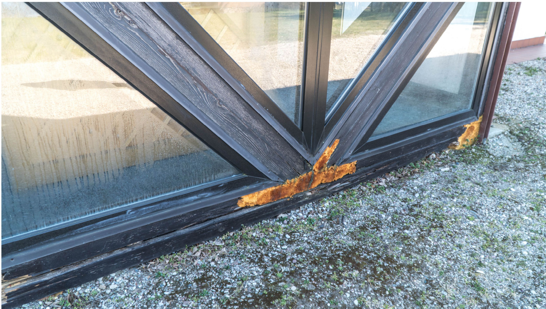
fragment posadowienia jednego z ryzalitów elewacji zachodniej
